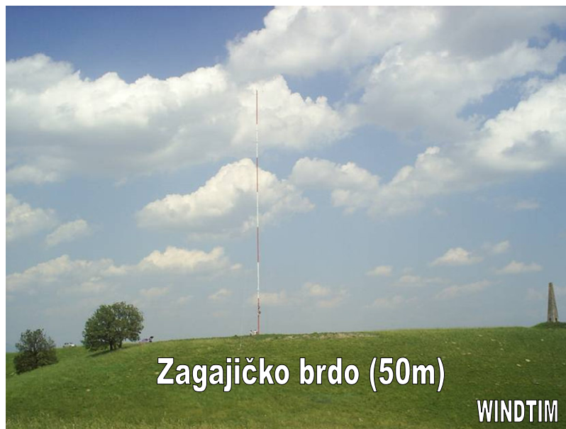
Izgled merne stanice za vetar na Zagajičkom brdu
